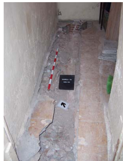
General final del tram de la rasa situada a l'interior de l'habitació del vestíbul.
