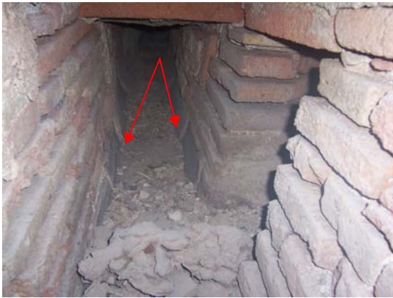
Vista sud de l'interior de la claveguera UE 112, abans de desmuntar la tapa UE 111. Es pot apreciar com el pis del canal presenta un arrebossat de ciment portland .
