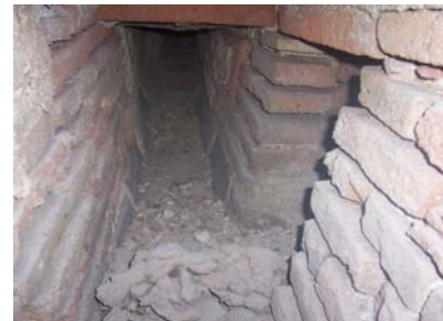
Vista de l'interior de la claveguera UE 112 abans del desmuntatge de la tapa (UE 111).
