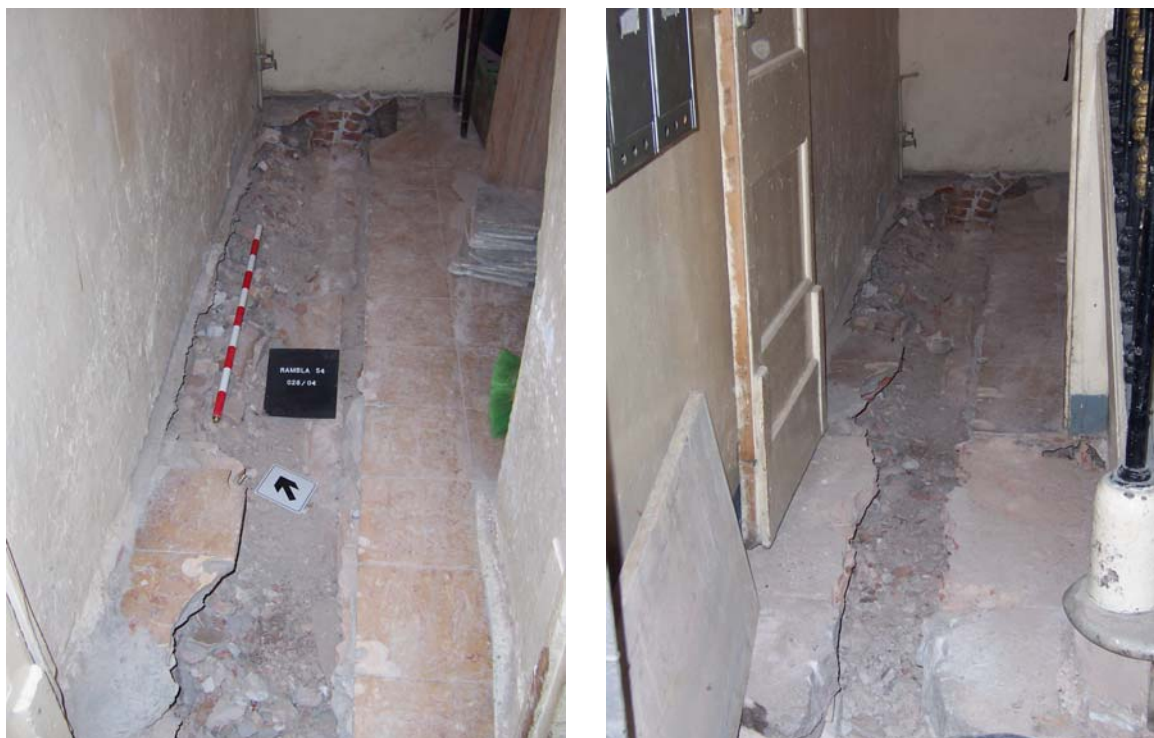
Dues imatges de l'estat final de la rasa practicada, al vestíbul i a l'habitació contigua, a la finca objecte d'actuació.
