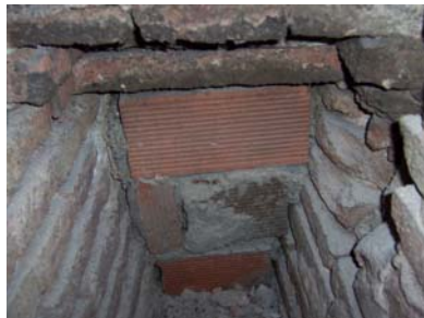
Vista de l'interior de la claveguera UE 107 i detall de laparet de totxo UE 113.
