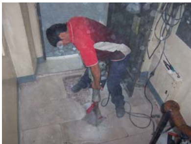
Vista dels treballs de desmuntatge i rebaix de la part de la UE 103 afectada per la cala i la rasa.
