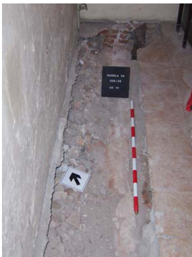
Vista de la claveguera UE 112.
