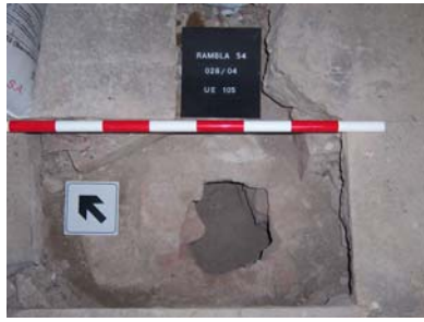
Detall de la tapa (UE 105) i del tram de claveguera UE 107 a la cala localitzada a l'entrada del vestíbul.
