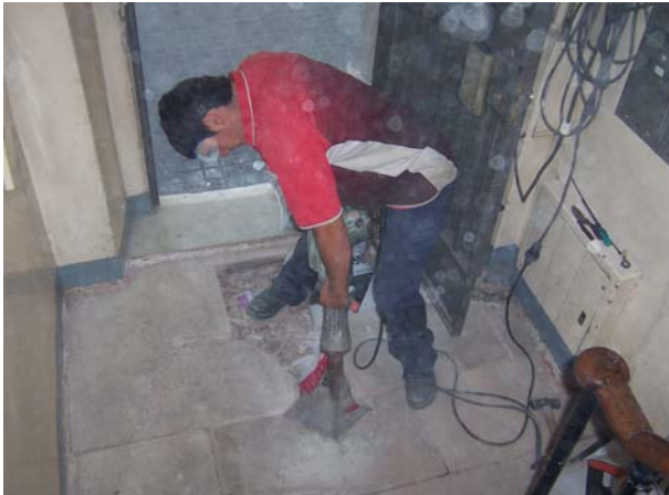
Treballs de desmuntatge de la part afectada pel rebaix de la UE 103.
