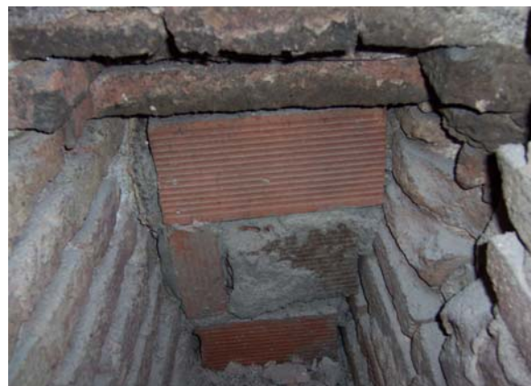
Vista de l'interior de la claveguera UE 107 i de la cara sud de la paret de totxo UE 113.
